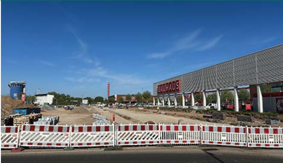
Der Höhenunterschied in der Eppelheimer Straße auf Höhe des Bauhauses wurde mittlerweile ausgeglichen. (Foto: Stadt Heidelberg)
